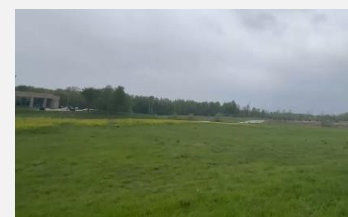
约克汤 (在建) 10MW
